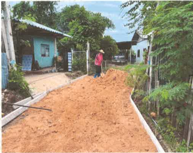
โครงการก่อสร้างถนนคอนกรีตเสริมเหล็ก บ้านซีเหล็กใหญ่ หมู่ที่ ๒ ตำบลมสุข งบประมาณทั้งสิ้น ๒๙,๐๐๐.- บาท
